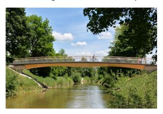
Die Fuß- und Radwegbrücke in Weinstadt ist nach dem Konzept der Stuttgarter Holzbrücke in integraler Bauweise ausgeführt. Dadurch ist das Auflager ideal geschützt und unempfindlich gegen Durchfeuchtung und LESS (Laub, Erde, Schnee und Splitt).
