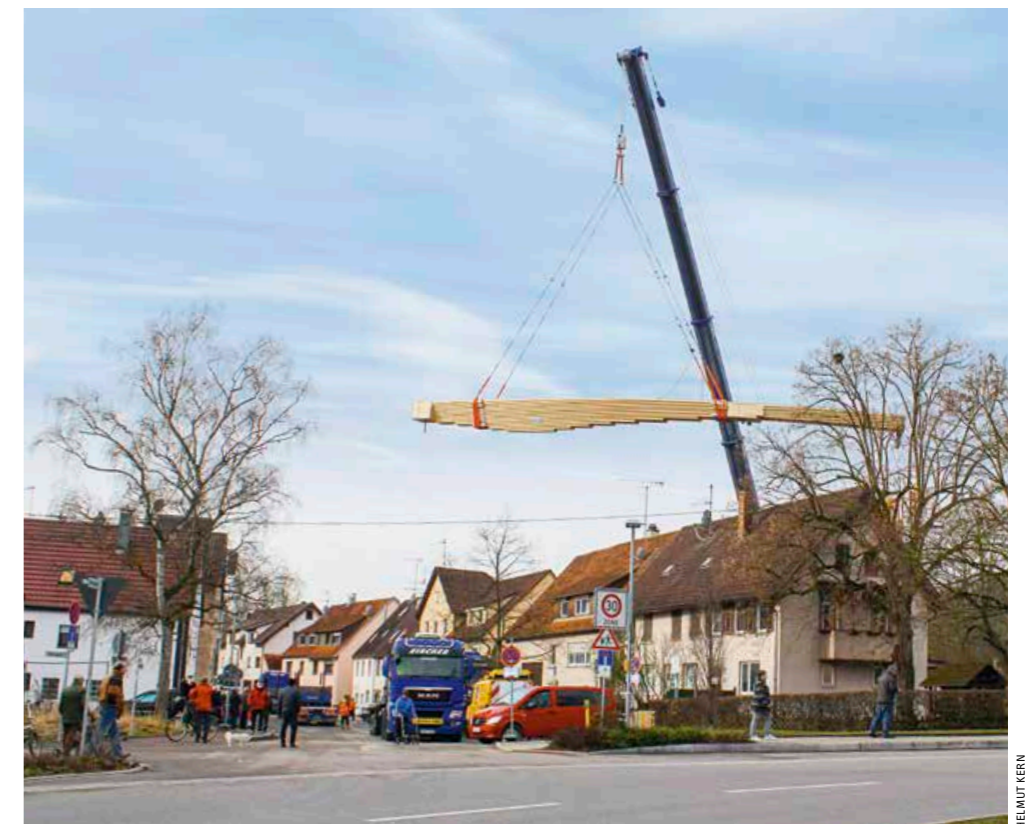
Der Aufbau war minutös geplant. Auf jeder Uferseite kam ein Kran zu Hilfe
