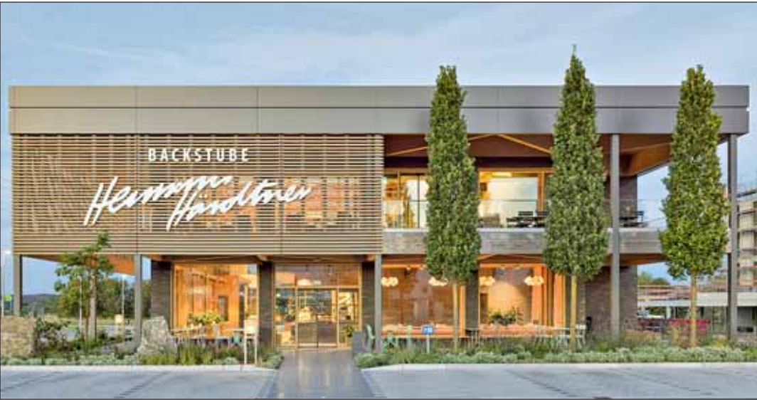
Zeitlos-moderne Holzbau-Architektur im Gewerbegebiet: Offene Lärchenholz-Rhombus-Schalung und ein weit auskragendes Flachdach
