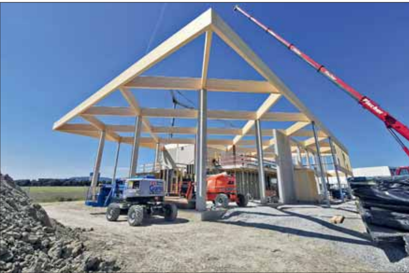
Das BSH-Dachgitter lagert auf Stahlbetonstützen.
