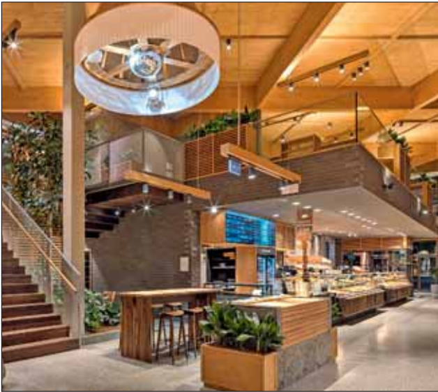
Das sichtoffene BSH-Dachtragwerk mit der Massivholz-Dachscheibe determinieren das offene Raumkonzept.
