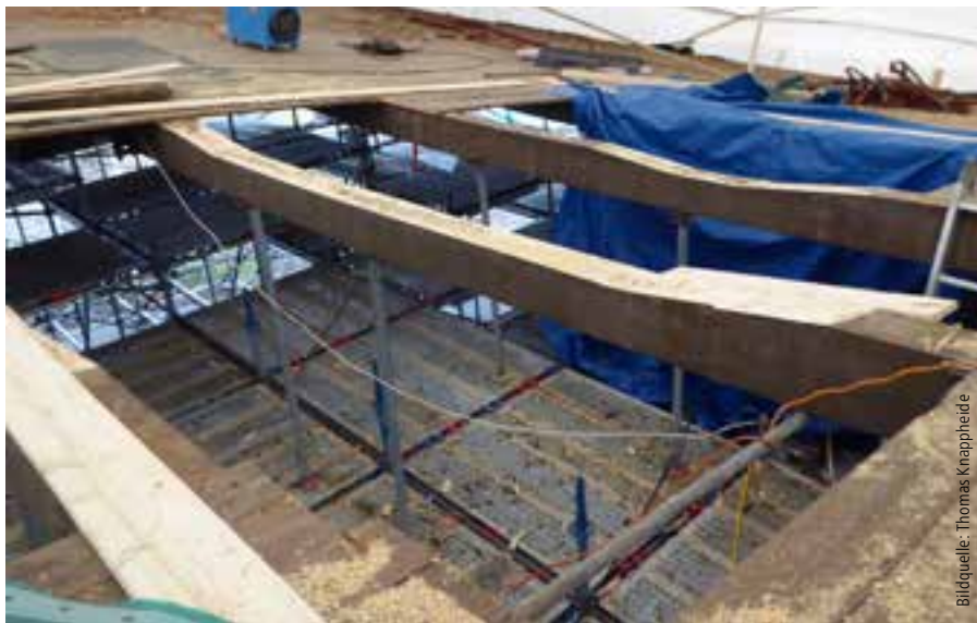
Die Nebenträger konnten durch die Zimmerei Risse mit zertifizierten Klebe-Schäftungsverbindungen ertüchtigt und so komplett erhalten werden.
