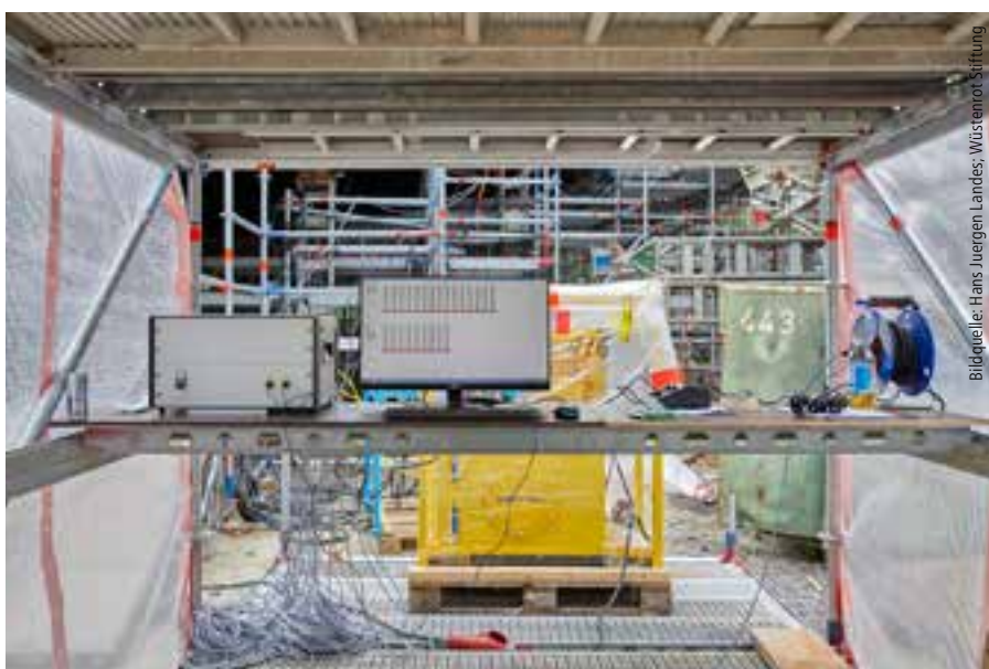
An einem Steuerstand mit großem Kontrollpanel wurde der Hebe- und Absenkvorgang überwacht.
