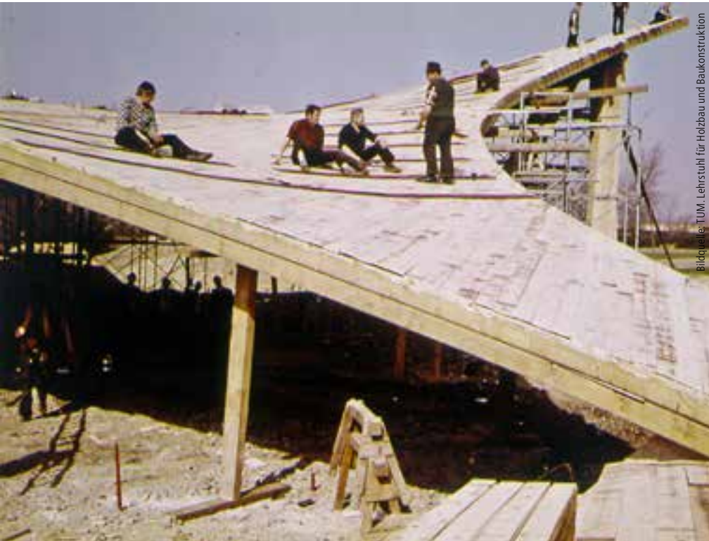
Das Sonnensegel im Westfalenpark in Dortmund, angefertigt für die dortige Bundesgartenschau 1969, diente als Demonstrationsobjekt für die Umsetzung freitragender Schalentragwerke aus Holz.
