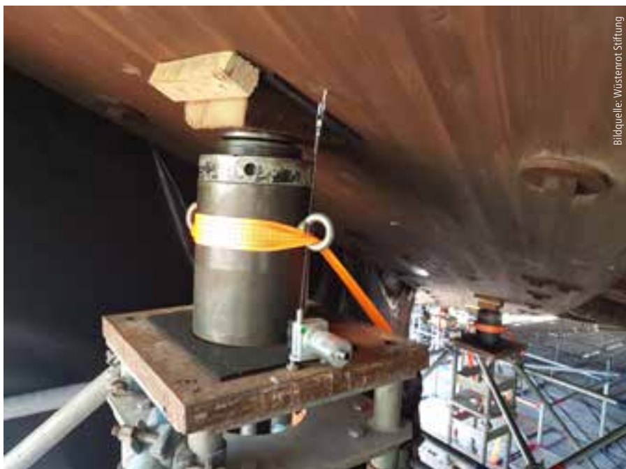
Mithilfe von Hydraulikstempeln an den Kopfpunkten der Schwerlaststützen wurde das Dach in die gewünschte Geometrie gebracht.
