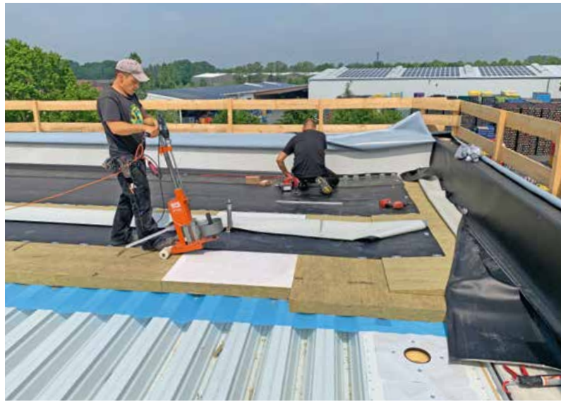
◀ Der Dachabschluss mit Trapezblech, Dampfbremsebahn, Steinwoll-dämmung und finaler EPDM-Bahn, auf die das Pflanzsubstrat zur Dachbegrünung aufgebracht wurde
