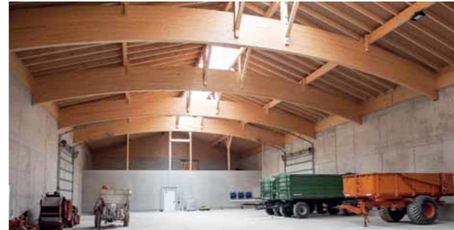
Das Holztragwerk besteht aus 8 Bogenbinder mit aufgeständerter Satteldachkonstruktion.
