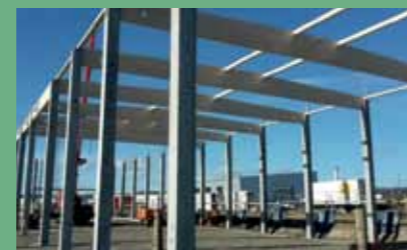
Produktion und Lieferung des F30-Holztragwerkes als Bausatz auf die Baustelle.
