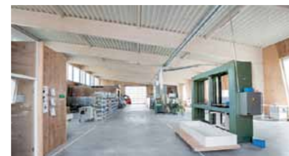
Die konisch zulaufenden Binder verjüngen sich zum First.
