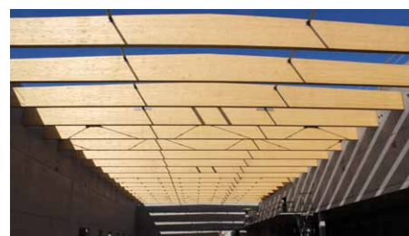
51 Satteldachbinder setzen warme Akzente.
