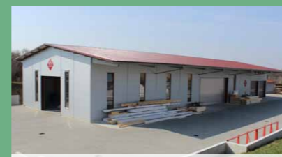
Bausatzlieferung der Handwerkerhalle und Selbstmontage durch die Zimmerei Kraft.
