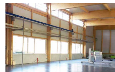
Tragwerk und Einspannstützen aus BS-Holz.
