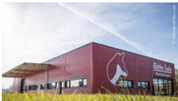
Ein Brettschichtholz-Tragwerk für Elektro Fuchs' neues Betriebsgebäude mit feuerroter Fassadengestaltung.
