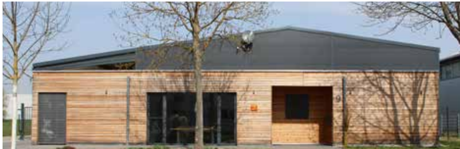
Der Büroanbau der Halle wurde mit einer Wandverkleidung aus Rhombusleistenschalung und einer Massivholzdecke aus Brettschichtholz als Kubus vor der Schreinerei montiert.
