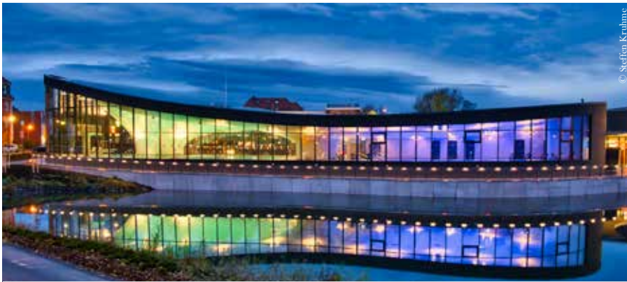
Die Schwimmhalle Ilmenau verbindet schlichtes Design mit einer ausdrucksstarken Form.
