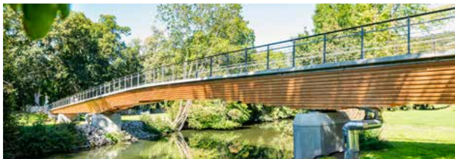
Die neue Fußgänger- und Radwegbrücke über die Tauber verbindet Innenstadt und Kurpark.
