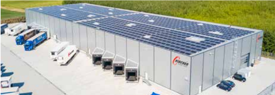
Die Hallen kommen bei einer Gesamtfläche von 4.800 m 2 mit lediglich acht Innenstützen aus.
