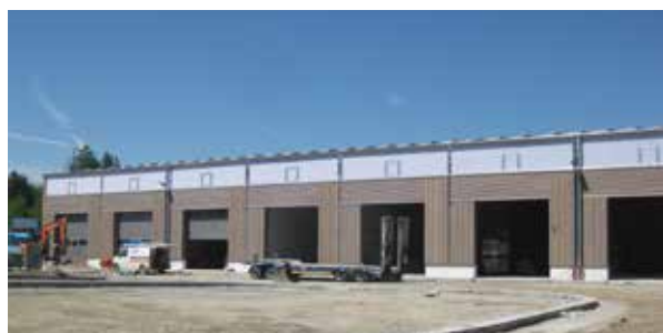
Die mit einer Vorvergrauungslasur gestrichene Lärchen-Fassade wurde im Vorfeld detailliert geplant.
