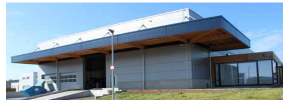
Die blaue Fassadenbahn zieht sich optisch einmal rings um die neue Produktionshalle.
