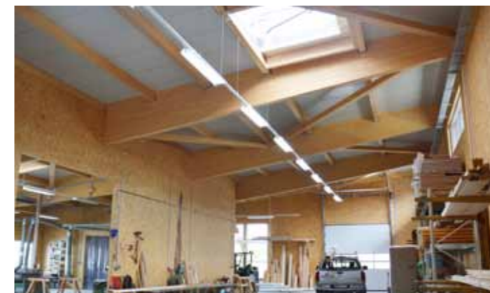
Die Brandschutzanforderung R30 ist mit einem Traggerüst aus Brettschichtholz problemlos erreichbar.
