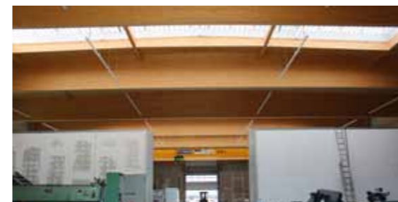
Die verbauten 330 m 3 Holz speichern rund 268 t CO 2 .
