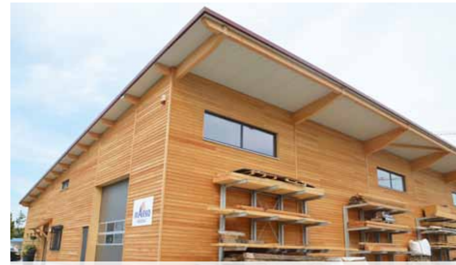
Die Halle überzeugt bereits von außen durch eine sägeraue, waagerechte Lärchenschalung.
