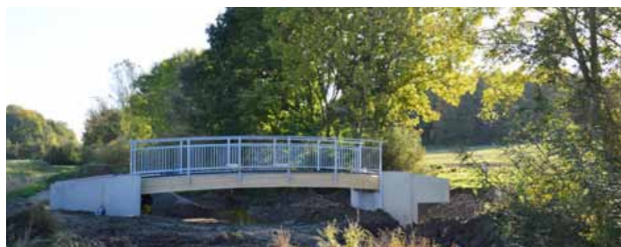
Die Montage dauerte aufgrund des hohen Vorfertigungsgrades nur wenige Stunden.
