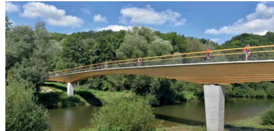
Die 96 m lange Fußgänger- und Radwegbrücke führt bei Neckartenzlingen über den Neckar und dient der Verbesserung des Neckartalradweges.
