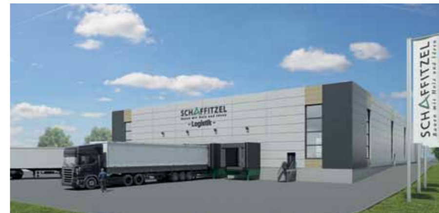
Die Schaffitzel Logistikhalle wurde speziell für die Bedürfnisse der Logistik entwickelt und kommt bei einer Fläche von 2.400 m 2 mit nur vier Innenstützen aus.
