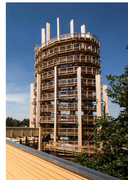
Der Aussichtsturm ist 40 m hoch und hat eine Plattform mit 12 m Durchmesser.
