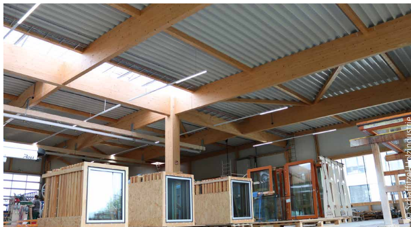
Zweischiffige Halle mit Parallelträgern und Unterzügen im Firstbereich, Epoxidholzstützen
