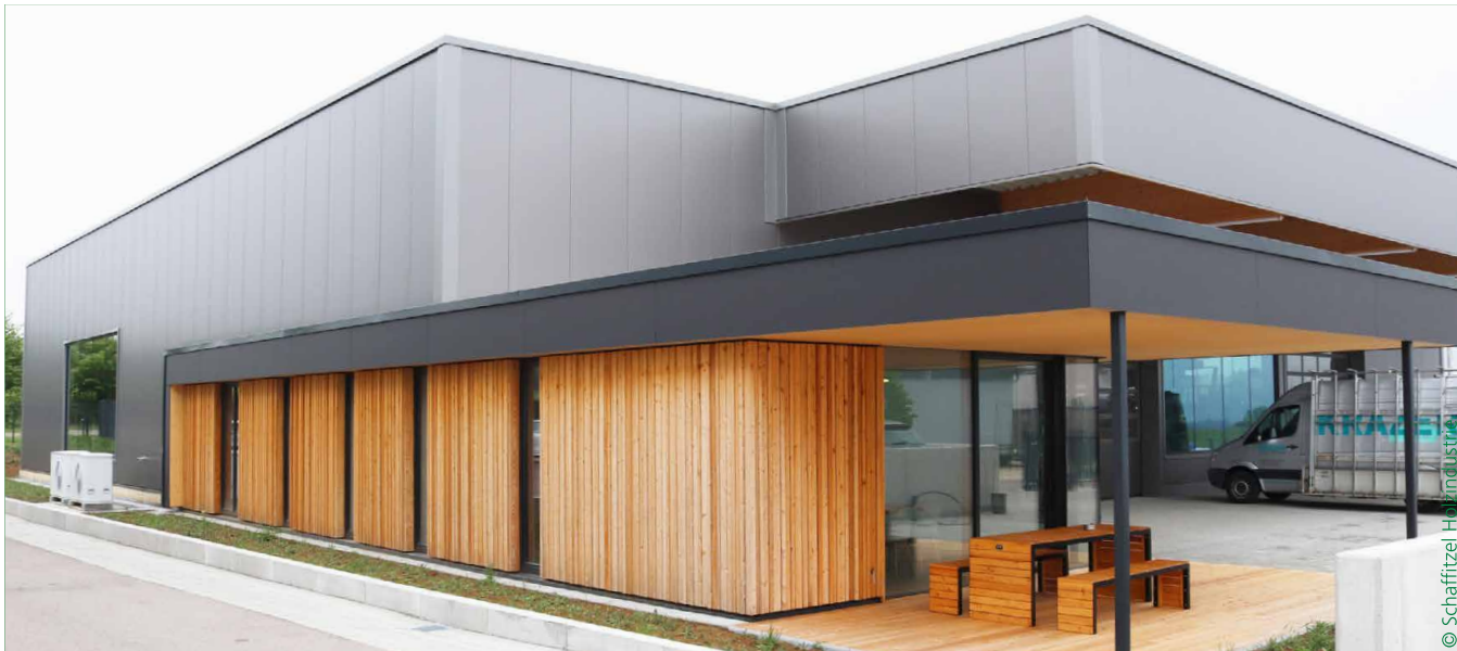
Produktionshalle mit eingeschobenem Bürotrakt und Freisitz. Die Fassade mit Holzverkleidung hebt sich optisch von den Sandwich-Paneelen ab.
