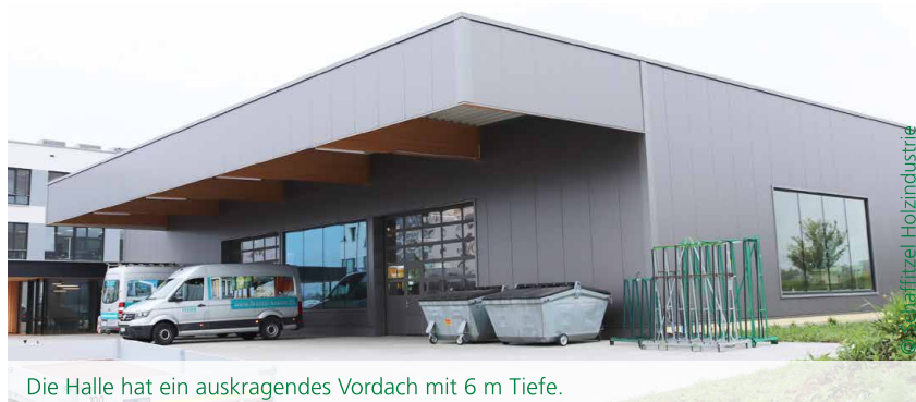
Zweischiffige Halle mit Parallelträgern und Unterzügen im Firstbereich, Epoxidholzstützen
