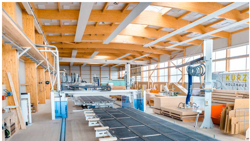
Die eingespannten Stützen der 2.900 m 2 großen Abbundhalle sind mit Epoxidharz beschichtet.
