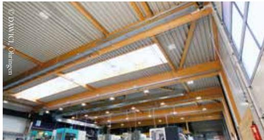
Eine stützenfreie Konstruktion aus Brettschichtholz.
