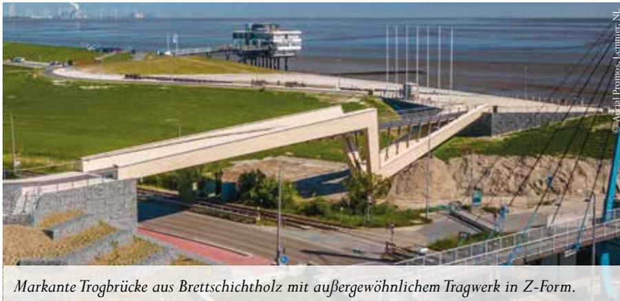
Markante Trogbrücke aus Brettschichtholz mit außergewöhnlichem Tragwerk in Z-Form.
