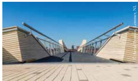
dem Ingenieurbüro Miebach wurde daher eine Trogbrücke aus blockverleimten Brettschichtholz (BSH) mit einem nach außen geneigtem Haupttragwerk entwickelt.
