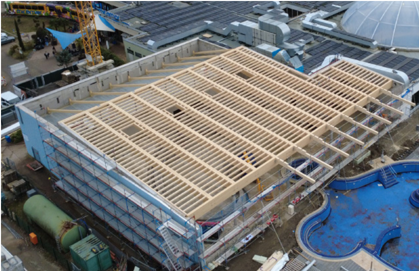
BSH-Hallentragwerk der nach dem Brand sanierungsbedürftigen Kristalltherme
