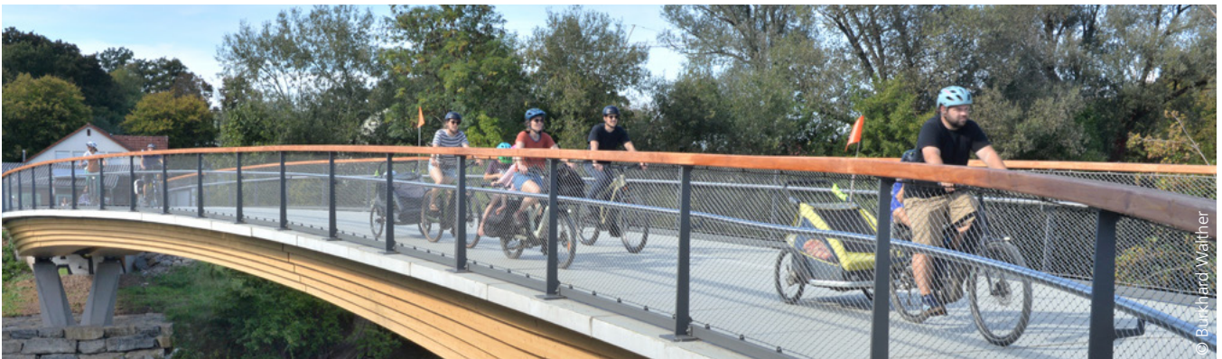
Geschwungene Blockträgerbrücke mit getrennter Fahrbahn für Radfahrer und Fußgänger mit Heizung für Nutzung zu allen Jahreszeiten
