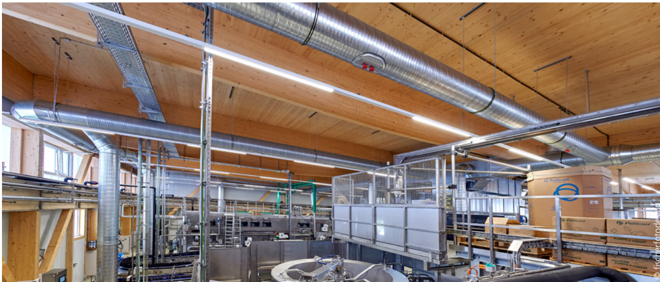
Die Halle der Alpirsbacher Klosterbräu wurde von vornherein so geplant, dass eine spätere Aufstockung um eine weitere Ebene möglich ist.
