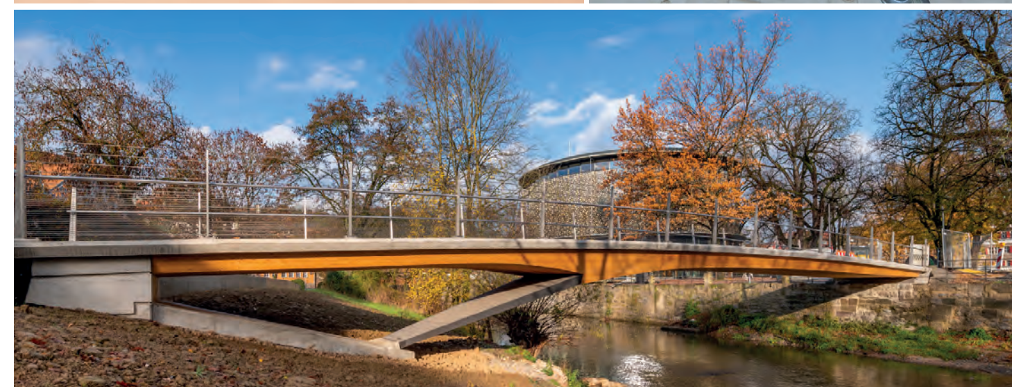
Die Lindachbrücke in Schwäbisch Hall ist als zweifeldrige Holz-Beton-Verbundbrücke ausgeführt. An einem der Widerlager ist der Brettschichtholzträger über den Holz-Beton-Verbund biegesteif in das Blockfundament eingespannt. Die markant geneigte Druckstrebe, welche statisch gesehen als Pendelstütze über ein Stahlhohlprofil ausgebildet wird, verleiht der Brücke ihren besonderen Schwung.
