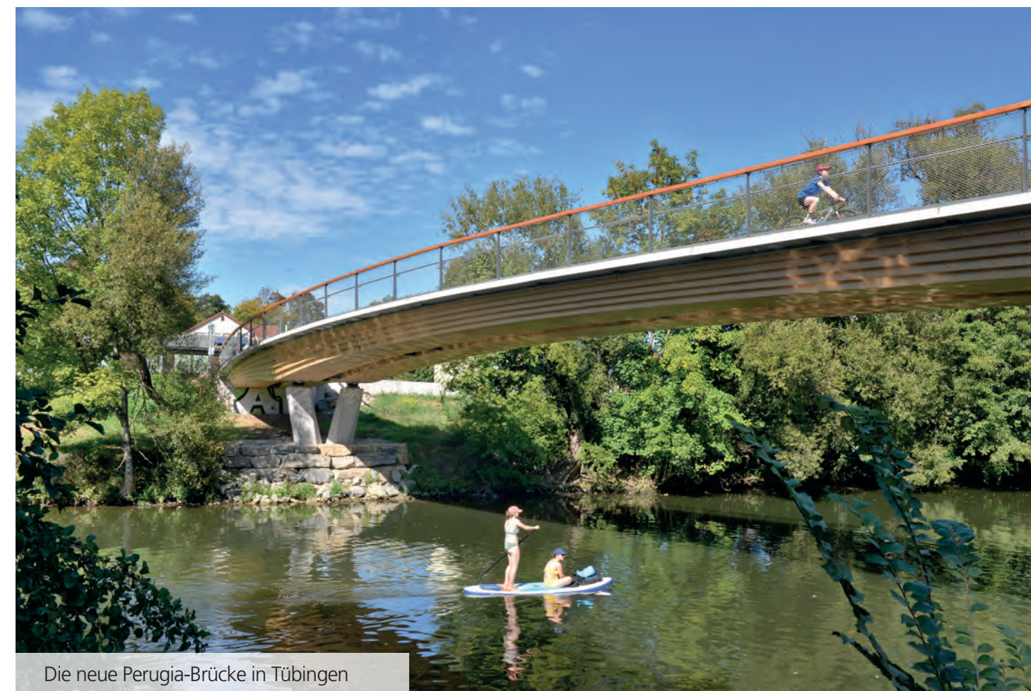
Die Blockträgerbrücke „Perugia“ in Tübingen basiert auf zwei gebogenen Brettschichtholzträgern, die ein Dreifeldsystem mit einer Gesamtlänge von knapp 70 Metern bilden. Die Felder sind längs durch Gerbergelenke verbunden, quer sind sie über Stahlrahmen gekoppelt.
