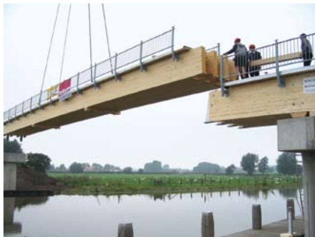
Bild 6 Das lange Mittelteil wird eingehoben, rechts gut erkennbar ist Auflagerung auf dem Gerbergelenk.
