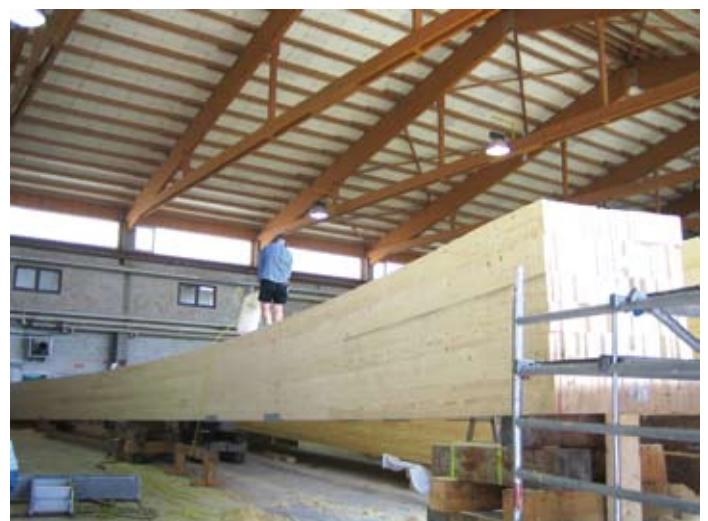
Bild 5 Eines der blockverklebten Teile für die Kurve in der Werkstatt
