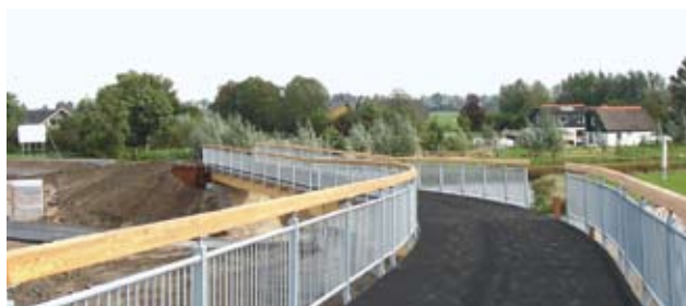
Bild 9 Die Sicht auf die Gehbahn
