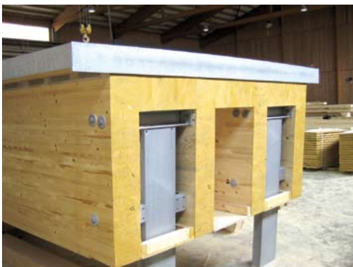
Bild 4 Das Träger-Ende nach Bild 3 montagefertig
