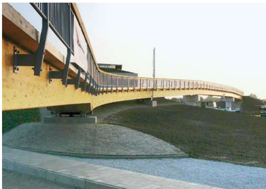
Bild 1 Die insgesamt 117 m lange Brücke bei Utrecht (Holland) hat fünf Felder, das längste überspannt 34 m. Ein Feld ist eine Kurve. Die im Grundriss geraden Brückenträger sind BS-Holz-Hohlkästen, die Kurve besteht aus zwei nebeneinander liegenden Vollquerschnitten
