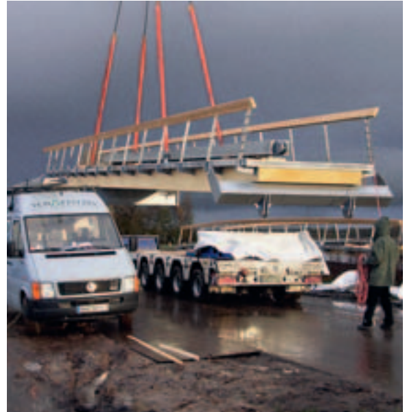
Bild links: Die 15 m lange hölzerne Fußgängerbrücke liegt direkt neben der Straßenbrücke aus Beton
