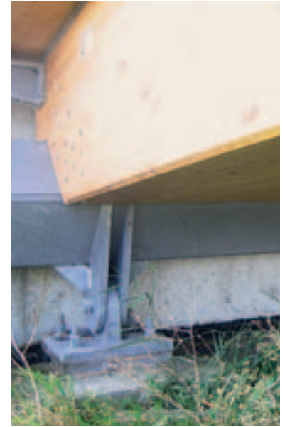
Das Widerlager der Pylonbrücke im Detail
