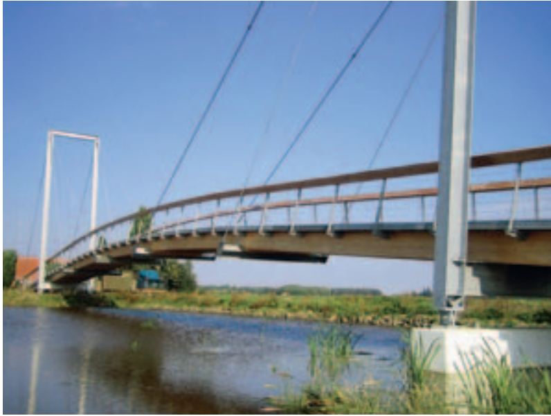
Holz spannt mit: Die „Mutter aller Brücken“ streckt sich mithilfe der Stahlpylone über eine Länge von 70 m
