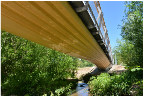
Fotos der Stuttgarter Holzbrücke in Urbach:
