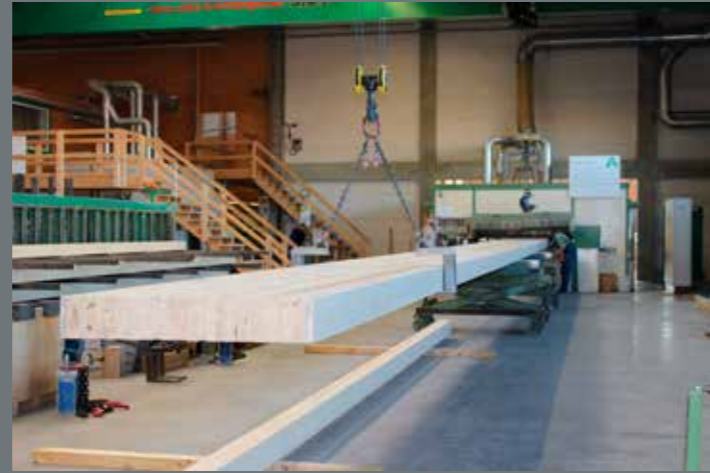
Danach werden die einzelnen Brettschichtholzlagen gehobelt und für die Blockverleimung vorbereitet
