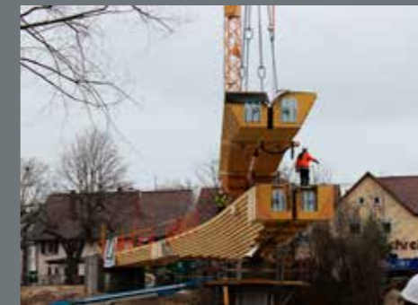
Das Einsetzen des Mittelteils der Brücke mit einer Länge von 24 m war ein besonderer Akt und bedurfte einer genauen Vorbereitung
