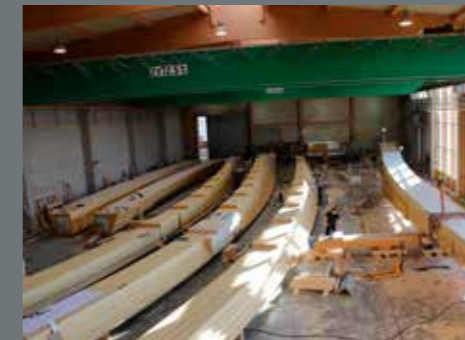
Vor der Montage der Beschläge werden die Brückenelemente mit einer Lasur gestrichen
