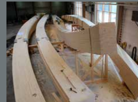
Nach dem Verleimen kommt nun der eigentliche Abbund mit diversen Fräsarbeiten
