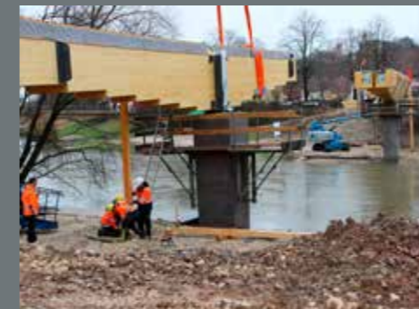
Das Einheben der Elemente beginnt: Auf dem Bild kann man erkennen, dass die Brückenabschnitte aus zwei Teilen bestehen
