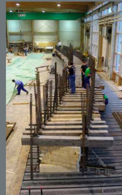
Die Blockverleimung der einzelnen Lagen, hier mit einer leichten Überhöhung, wird mittels Holz-zulagen hergestellt
