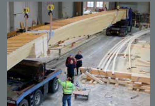
Mehrere Schwertransporter bringen die Brückenelemente nach Neckartenzlingen
