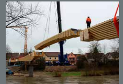
Aufgrund der großen Ausladung und des Gewichts des Mittelteils wurde beim sogenannten Brückenschlag ein 500 t Autokran eingesetzt
