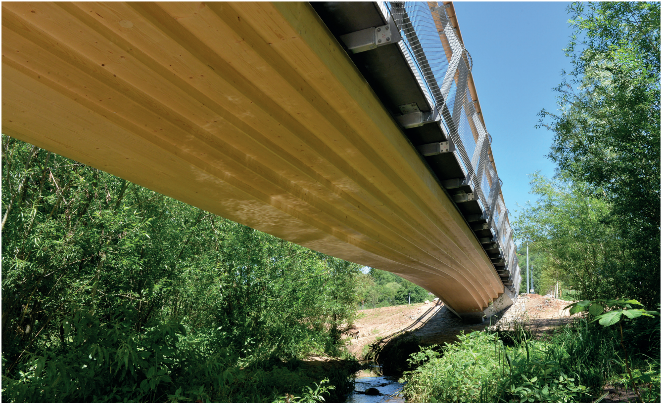
Die Brücke „Urbacher Mitte“ ist nach dem Konzept der Stuttgarter Holzbrücke entstanden. Abb.: Schaffitzel Holzindustrie/Fotograf Burkhard Walther
