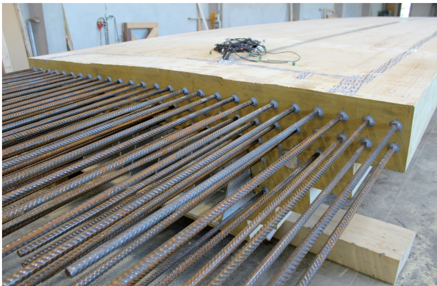
Ein Messsystem überwacht die Holzfeuchte der Brücke. Abb.: Schaffitzel Holzindustrie GmbH + Co. KG
