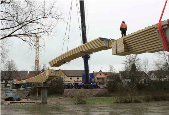
4 Im Mittelfeld der Brücke wurden zwei Gerbergelenke angeordnet. So ergeben sich bei der Montage von den Widerlagern ausgehend zwei Einfeldträger mit Kragarm. Ein Einhängeträger verbindet sie und vervollständigt das System zum Dreifeldträger.
