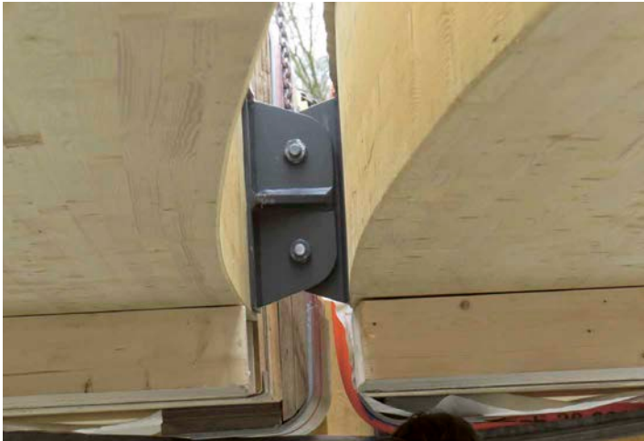
7 Die Querschotts verbinden die beiden Trägerhälften miteinander. Auf diese Weise wird die Torsionssteifigkeit des gesamten Brückenkörpers erhöht.
