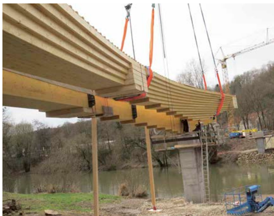
5 Wegen ihrer Krümmung war der Transport der Kragträger nur in vier Teilen möglich. Die Brücke wurde daher aus fünf Einzelteilen montiert. Zur Baustelle kamen vier „halbe Einfeldträger mit Kragarm“ und das Mittelstück. Letzteres ließ sich als gerades Trägerteil komplett vorgefertigt anliefern.
