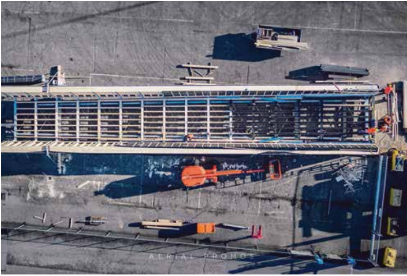
◀ Vormontierter Brückenteil mit Trägerrost für die Gehbahn
