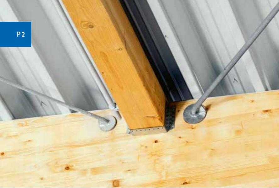
◀ Detailausschnitt der Dachkonstruktion
