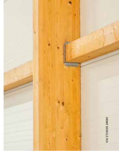
▶ Die Wände sind als Pfosten-Riegel-Konstruktion ausgeführt
