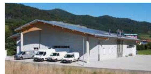
Die Brettspertholzwände sind außen mit Dämmung versehen und mit Stahltrapezblechprofilen abgedeckt.
