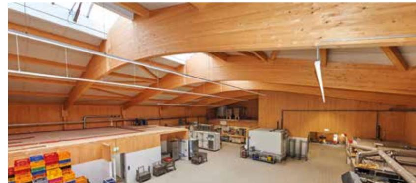
Die neue Produktionshalle der Bäckerei Burger hat nicht nur ein komplettes Tragwerk aus Brettschichtholz, auch Wände und Deckenelemente sind in Brettspertholz ausgeführt.
