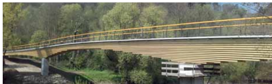
Die Neckartenzlinger Brücke ist eine innovative, moderne Brücke mit hohem ökologischem Wert, die sich mit eigener Ästhetik in die Umgebung einfügt und rund 207 t CO 2 bindet.
