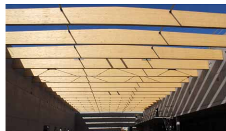
51 Satteldachbinder setzen warme Akzente.
