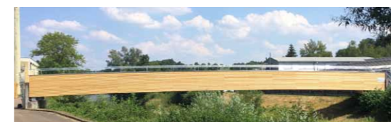
Das Tragwerk ist durch die waagrechte Lärchenverschalung und durch eine oberseitige Abdeckungen geschützt.
