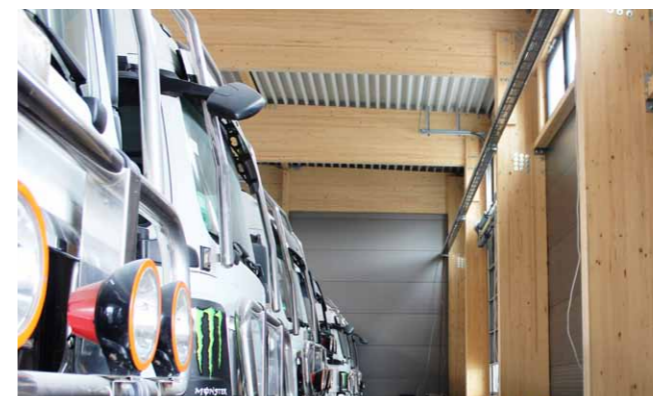
Sven Quandt, Geschäftsführer von X-Raid, entschied sich beim Bau seiner Lagerhalle für ein komplettes Tragwerk aus Holz.
