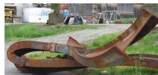
Verkrümmter Stahlträger nach dem Brandfall.
