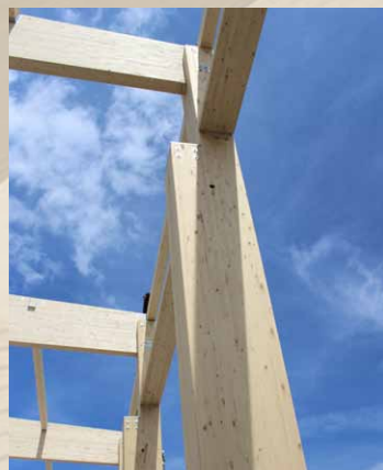
Die Kranen der Halle liegen auf Kranbahnstützen, die mit Epoxidharz eingespannt sind.
