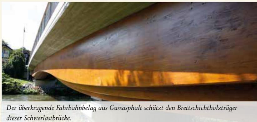
Der überkragende Fahrbelag aus Gussasphalt schützt den Brettschichtholzträger dieser Schwerlastbrücke.
