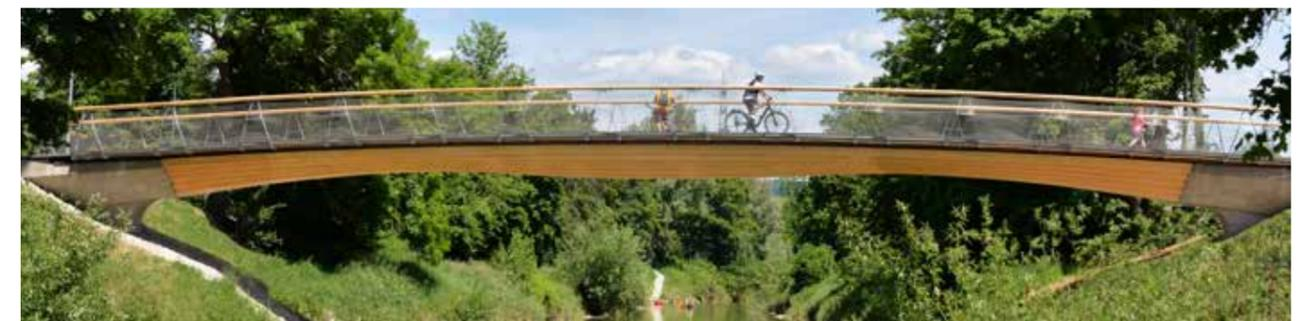
Die neue Fuß- und Radwegbrücke in Weinstadt ist nach dem Konzept der Stuttgarter Holzbrücke in integraler Bauweise ausgeführt. Dadurch ist das Auflager ideal geschützt und unempfindlich gegen Durchfeuchtung und LESS (Laub, Erde, Schnee und Splitt).
