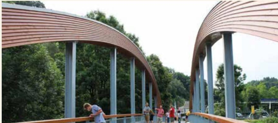
Diese Bogenbrücke wurde für den konstruktiven Schutz seitlich mit Lärchenholz verkleidet und oberseitig mit einem Titanzinkblech abgedeckt.
