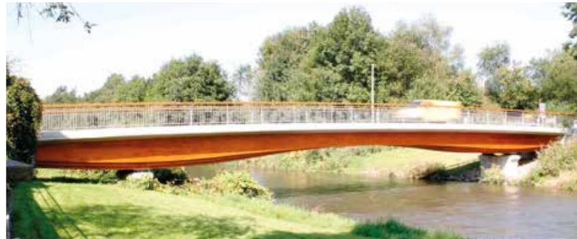
Die Brücke beugt durch ihren „Schwung“ zukünftigen Hochwasserschäden vor. Das Tragwerkskonzept macht den Kraftverlauf in den Trägern durch die Formgebung elegant sichtbar.
