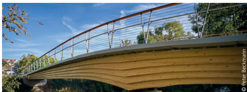
Zweifeldrige Blockträgerbrücke in Frankenberg/Eder: Länge 60,00 m, Breite 4-5 m
