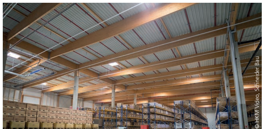
Primärdachtragwerk aus 24 m frei gespannten Fischbauchbindern, angeschlossen an BSH-Unterzüge
