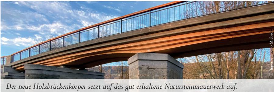
Der neue Holzbrückenkörper setzt auf das gut erhaltene Natursteinmauerwerk auf.
