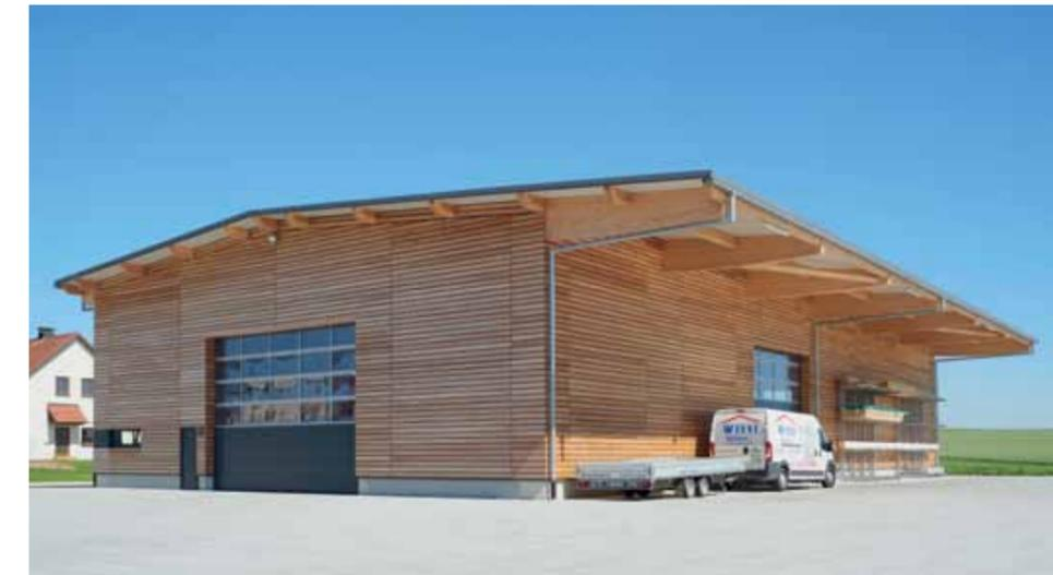
Ein Hallenbau mit einem Tragwerk aus Brettschichtholz überzeugt sowohl im Preis-Leistungsverhältnis als auch mit einer Fülle technischer und ökologischer Vorteile. Zum Beispiel ist durch einen hohen Vorfertigungsgrad im Werk eine schnelle und durchgehende Montage des Tragwerks möglich. Günstigere Rohbaukosten wegen kleinerer Fundamente können zu einem wirtschaftlicheren Gesamtergebnis beitragen. Holz bietet als einziger Baustoff die Möglichkeit, im Bauwerk mehr CO<sub>2</sub> zu spei-
