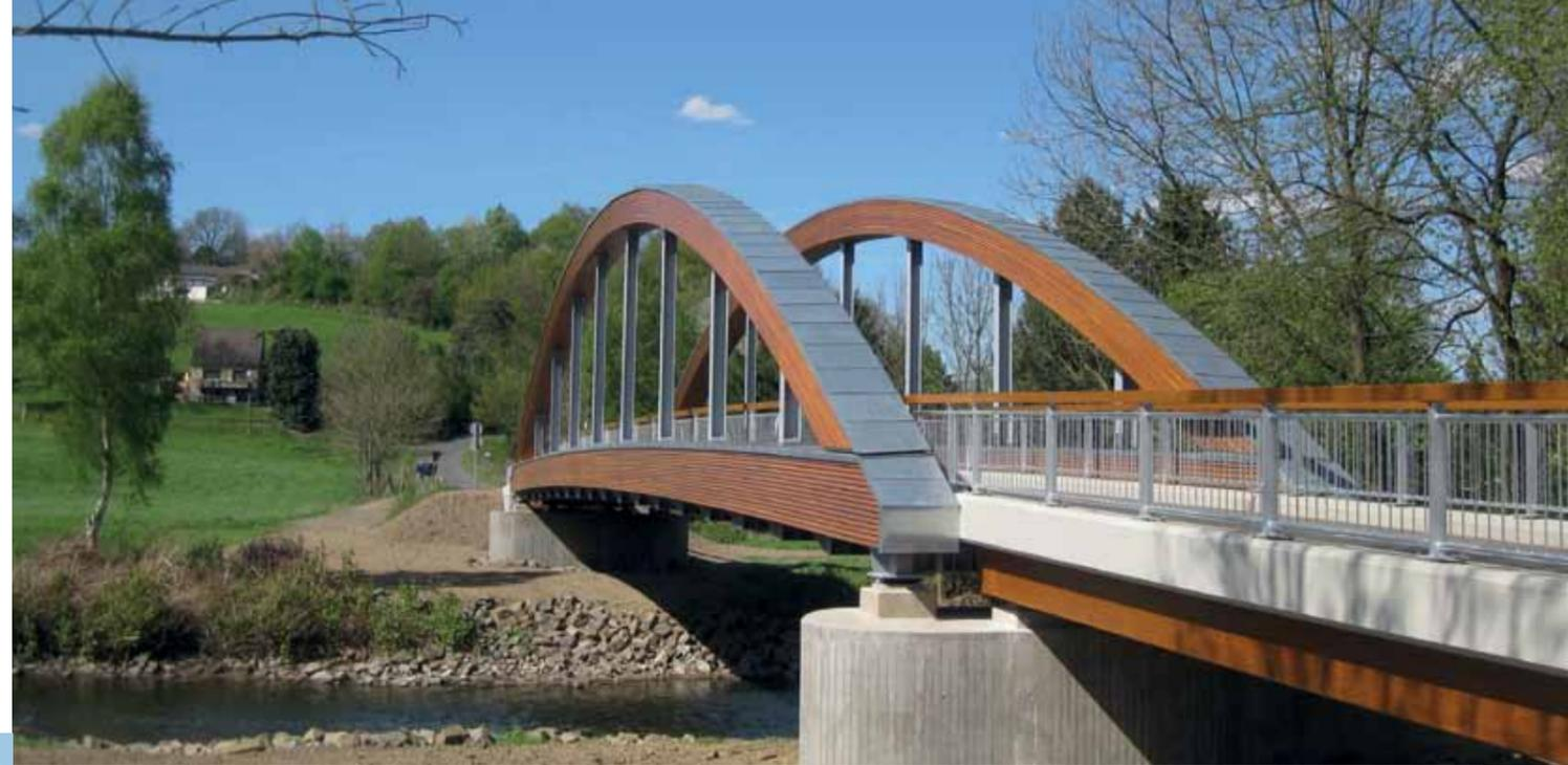
Mit 45 m Spannweite ist die „Höngesberger“-Brücke bei Lohmar einer der längsten Holz-Bogenbrücken Deutschlands und zudem für Verkehr bis 12 t ausgelegt. Sie ist die sinnvolle Kombination zweier Tragwerksformen: Das Flussbett der Agger wird durch die Bogenkonstruktion stützenfrei überspannt und der Überbau der Vorlandbereiche wird als Holz-Beton-Verbundkonstruktion ausgeführt, die im Hochwasserfall einen zusätzlichen Abflussquerschnitt bieten.
