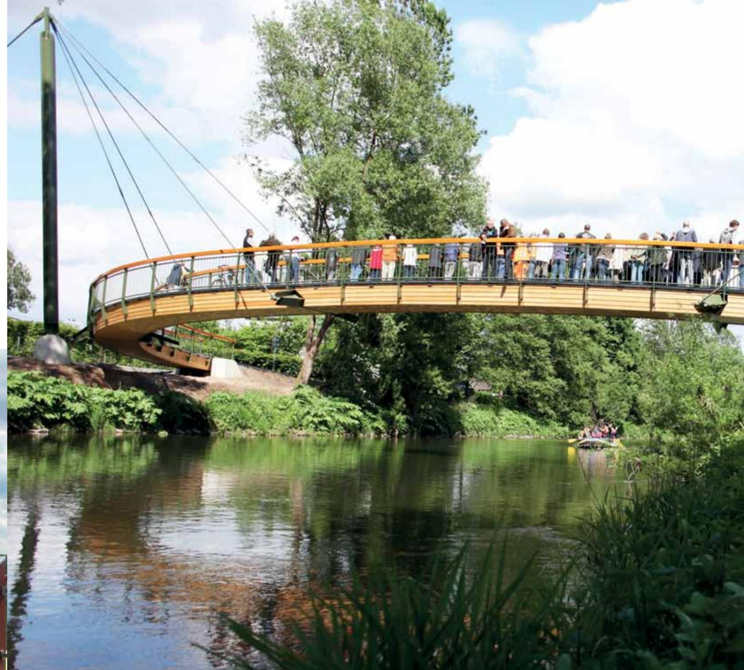
Die Pylonbrücke „Aggerbogen“ bei Lohmar bietet durch ihren S-förmigen Grundriss einem Hochwasser sehr wenig Staufläche. Der Belag ist aus Natursteinplatten, sodass diese Brücke sich sowohl durch die gebogene Anordnung des Brückenkörpers als auch durch die verwendeten Materialien äußerst harmonisch ins Naturschutz- und Radwandergebiet einfügt.
