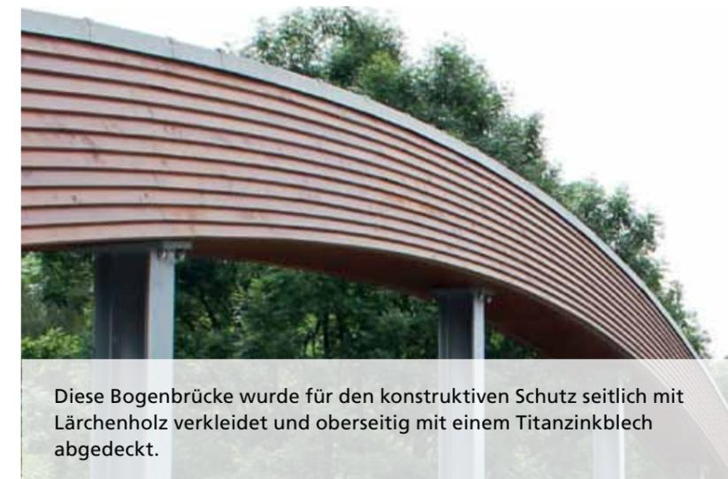
Diese Bogenbrücke wurde für den konstruktiven Schutz seitlich mit Lärchenholz verkleidet und oberseitig mit einem Titanzinkblech abgedeckt.
