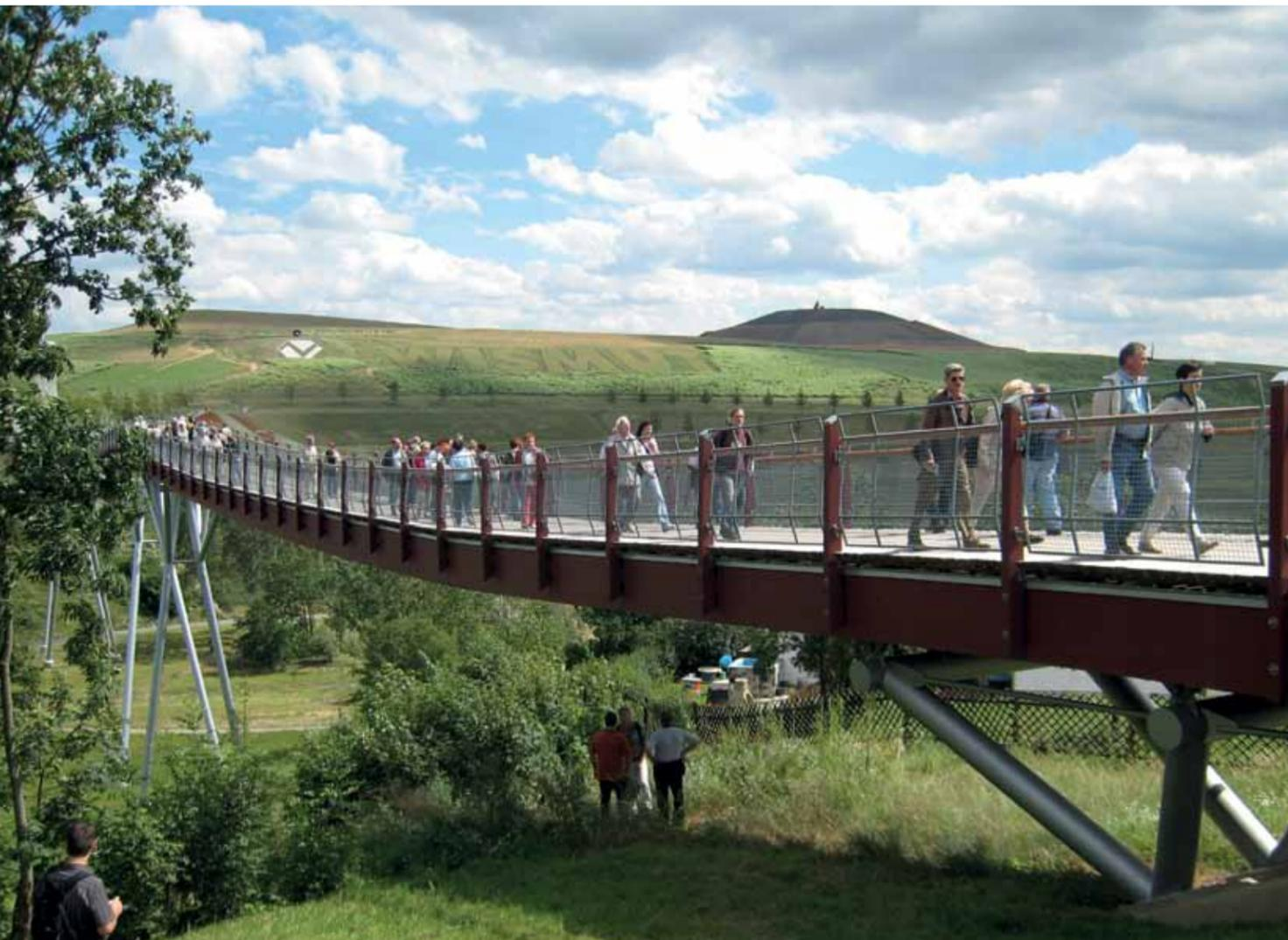
Für die Bundesgartenschau im thüringischen Gera wurde über das Gessental eine Fuß- und Radwegbrücke der besonderen Länge konzipiert. Erstmals wurde ein blockverklebter Brett-schichtholzträger als 225 m langes Spannband eingesetzt. Bohlen des wetterbeständigen Lärchenholzes dienen als Belag dieser Brücke mit dem passenden Namen „Drachenschwanz“.
