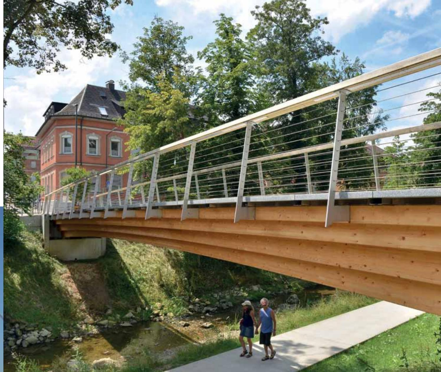
Der Schillersteg in Schwäbisch Gmünd ist eine Blockträgerbrücke, die für die Landesgartenschau 2014 errichtet wurde. Erstmals wurden 7 cm dicke Natursteinplatten als Belag eingesetzt.
