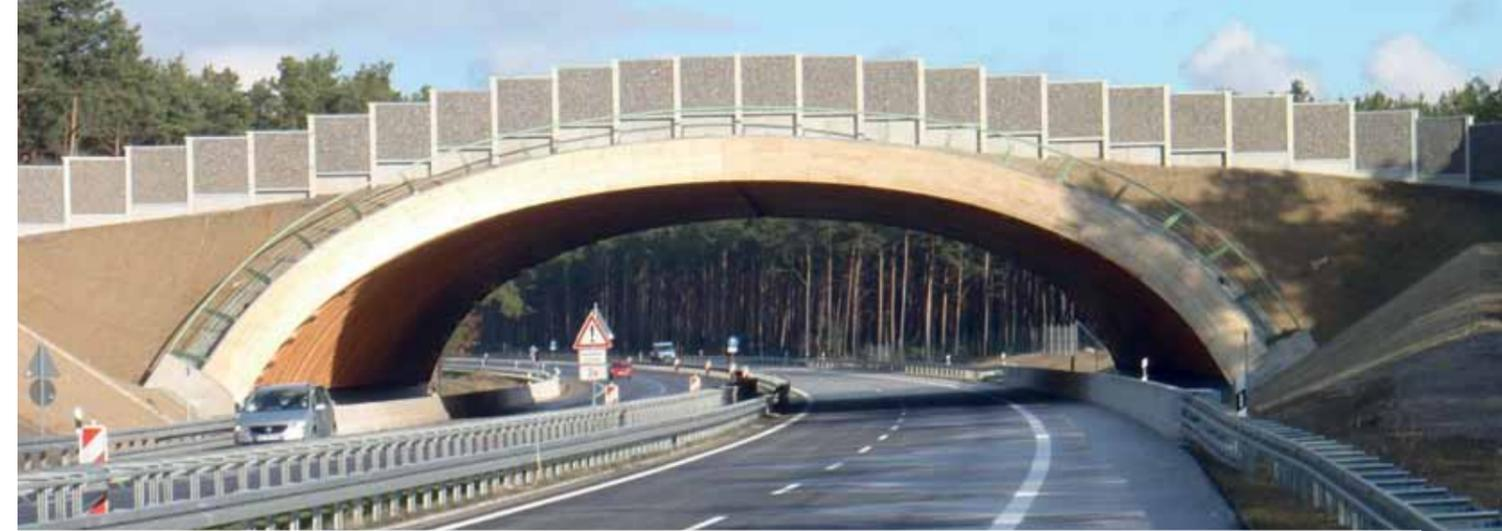
Die fertiggestellte Wildbrücke in Luckenwalde. Sie hat geholfen, die tödlichen Wildunfälle auf der Bundesstraße B 101 von 10-12 im Jahr auf Null zu reduzieren. Das erdüberschüttete Bogentragwerk wurde mit einer Brettsper Holzdecke und einem mehrlagigen Abdichtungs-Sonderaufbau überspannt.
