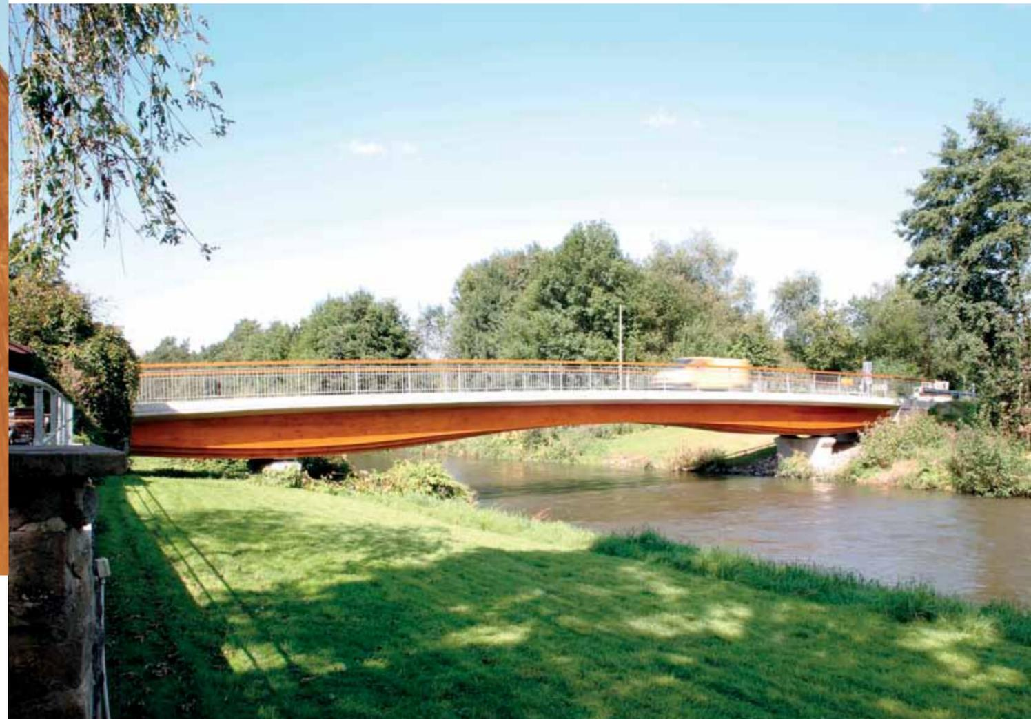
Die Schwerlastbrücke „Schiffarth“ in Holz-Beton-Verbundbauweise bei Lohmar reizt die statischen Eigenschaften der beiden Baustoffe optimal aus. Um den Blockträger in der Feldmitte zusätzlich zu entlasten, wurden die Endbereiche am Widerlager mit Zugstäben rückverankert. Auf diese Weise wurde zugleich eine geringere Bauhöhe erzielt
