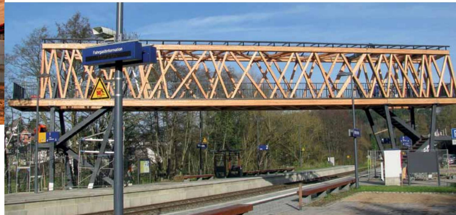
In einer nächtlichen Aktion wurde die neue, bahnquerende Brücke aus Lärchenbrettschichtholz in Nettersheim aufgebaut. Die Holzkonstruktion hat eine asymmetrische Tragstruktur, die auf zwei Stahl-Stützenkonstruktionen auflagert, welche zugleich die Treppenaufgänge aufnehmen.
