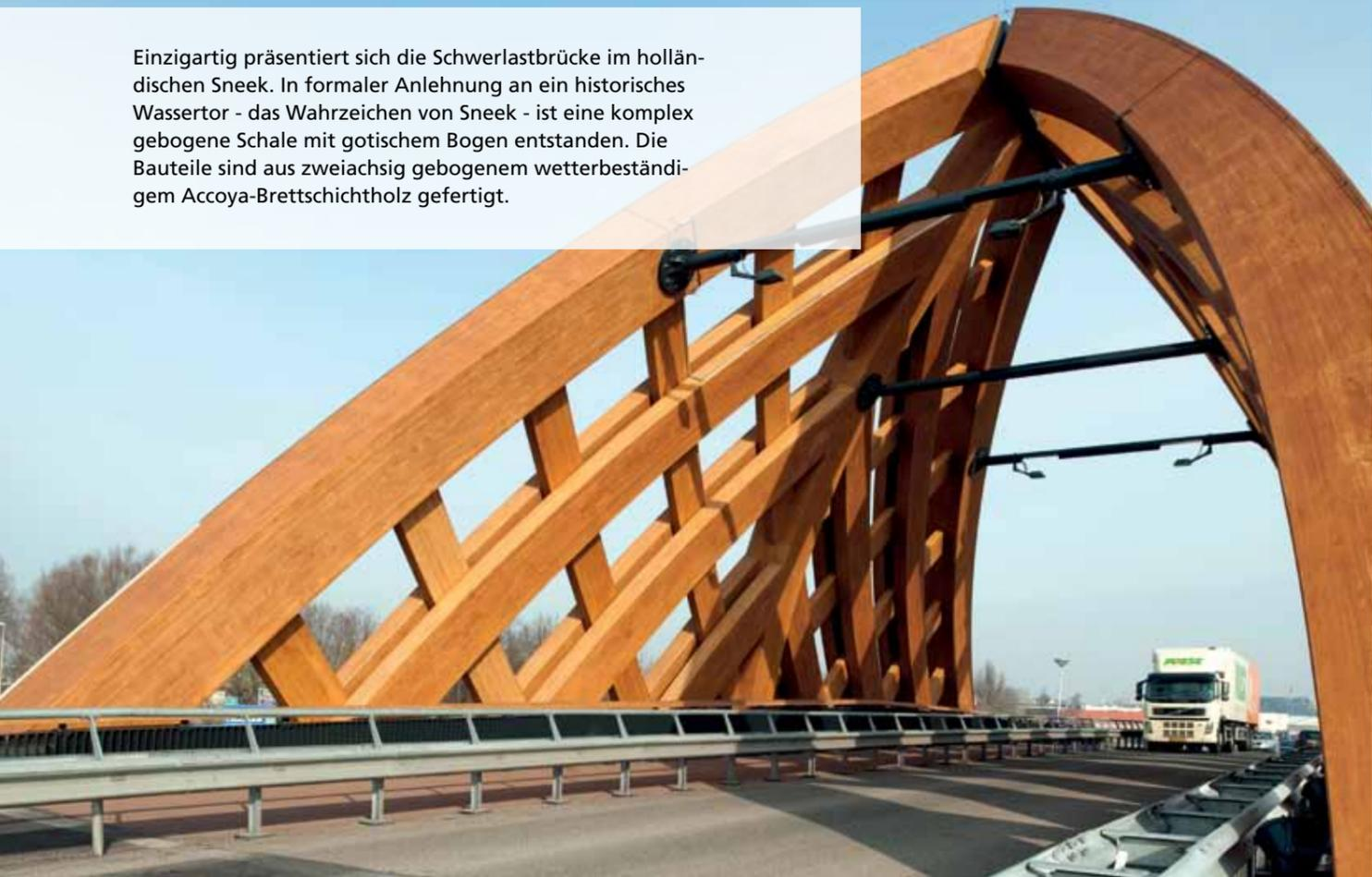
Wir haben vielfältige Lösungen für Brücken, die schwere Lasten tragen können. Insbesondere die Holz-Beton-Verbundbauweise eignet sich für den Straßenbrückenbau im Stützweitenbereich zwischen 10 und 30 Metern. Eine optimale Ausnutzung der positiven Materialeigenschaften beider Baustoffe wird erreicht, wenn der Beton in der
