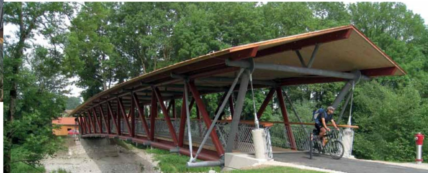
Diese überdachte Fachwerkbrücke überspannt 50 m freitragend die bayerische Traun bei Pertenstein und wirkt doch transparent, modern und leicht. Sie ist gefertigt aus rund gedrehten Stützen und Diagonalen aus Brettschichtholz.
