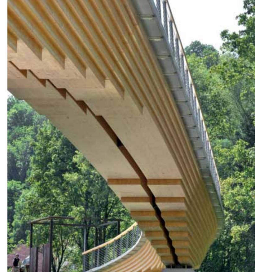
Sowohl für eine effiziente Materialausnutzung als auch aus Gründen des konstruktiven Holzschutzes wird der Holzquerschnitt gegenüber der Betonplatte parabelförmig zurückversetzt.
